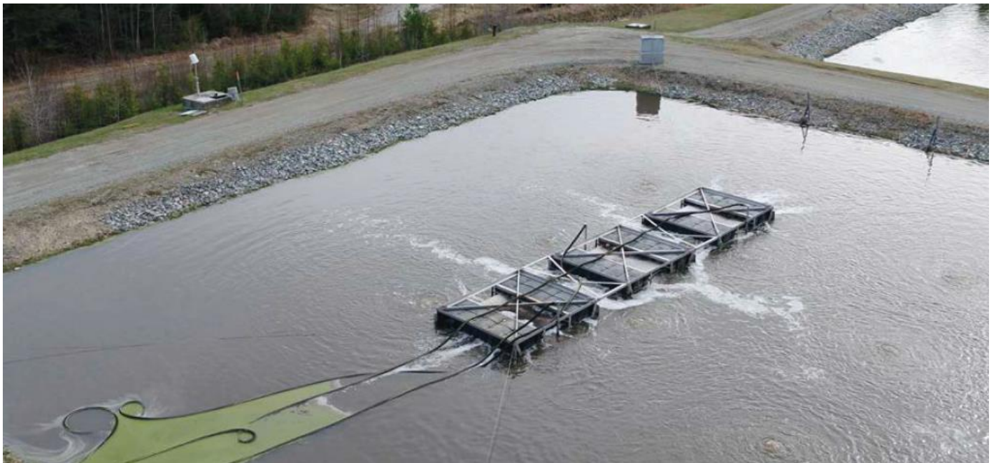
Vue des modules ECOFIXE après installation
