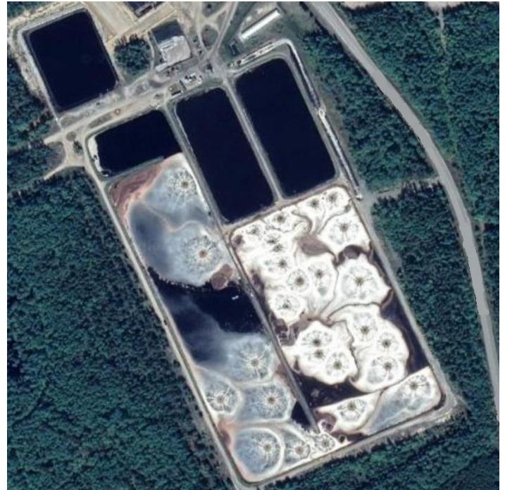
Installation d'étangs aérés
